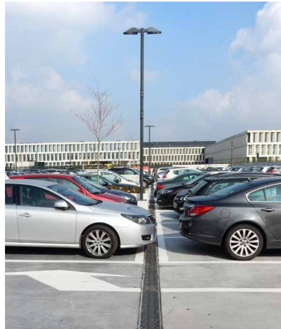
De goten op de parking zijn uitgerust met een specifiek rooster om fietsers en mensen met een mobiele beperking niet al te zeer te hinderen.
